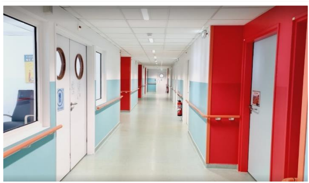
L'Unité HTSH située au niveau 2 du bâtiment A
